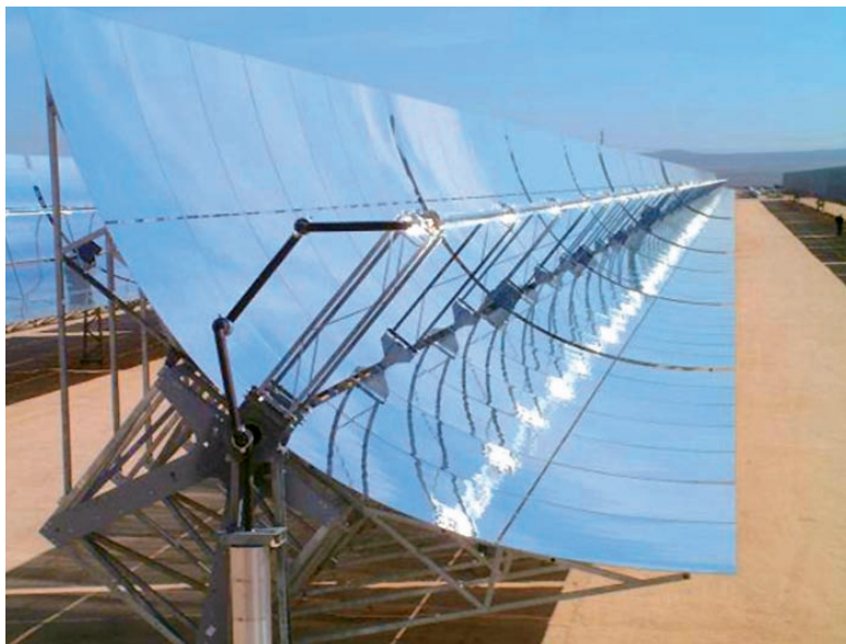
Fig. 8. Un concentratore parabolico lineare della centrale solare termoelettrica Andasol 1 di 50 MW, nel sud della Spagna. Si tratta della prima centrale commerciale europea con concentratori parabolici lineari e con accumulo termico a sali fusi.
