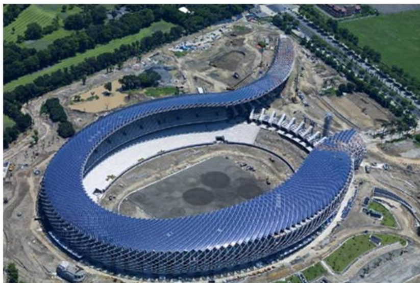
Fig. 3 – Kaohsiung World Stadium di Taiwan: il primo stadio al mondo ad essere alimentato con pannelli fotovoltaici.
