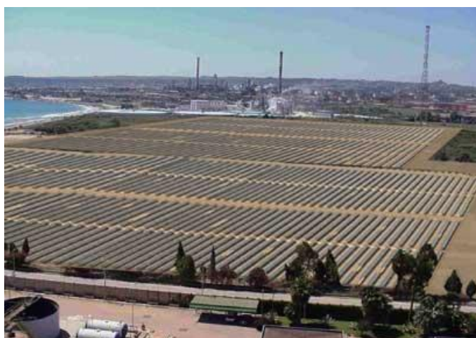
Figura 6 – Ricostruzione fotografica dell'impianto Archimede
