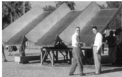
Figura 7 – La pompa solare Somor, esposta in occasione del Simposio Mondiale sulle Applicazioni dell'energia solare tenuto a Phoenix nel 1955 (Archivio ISES).
