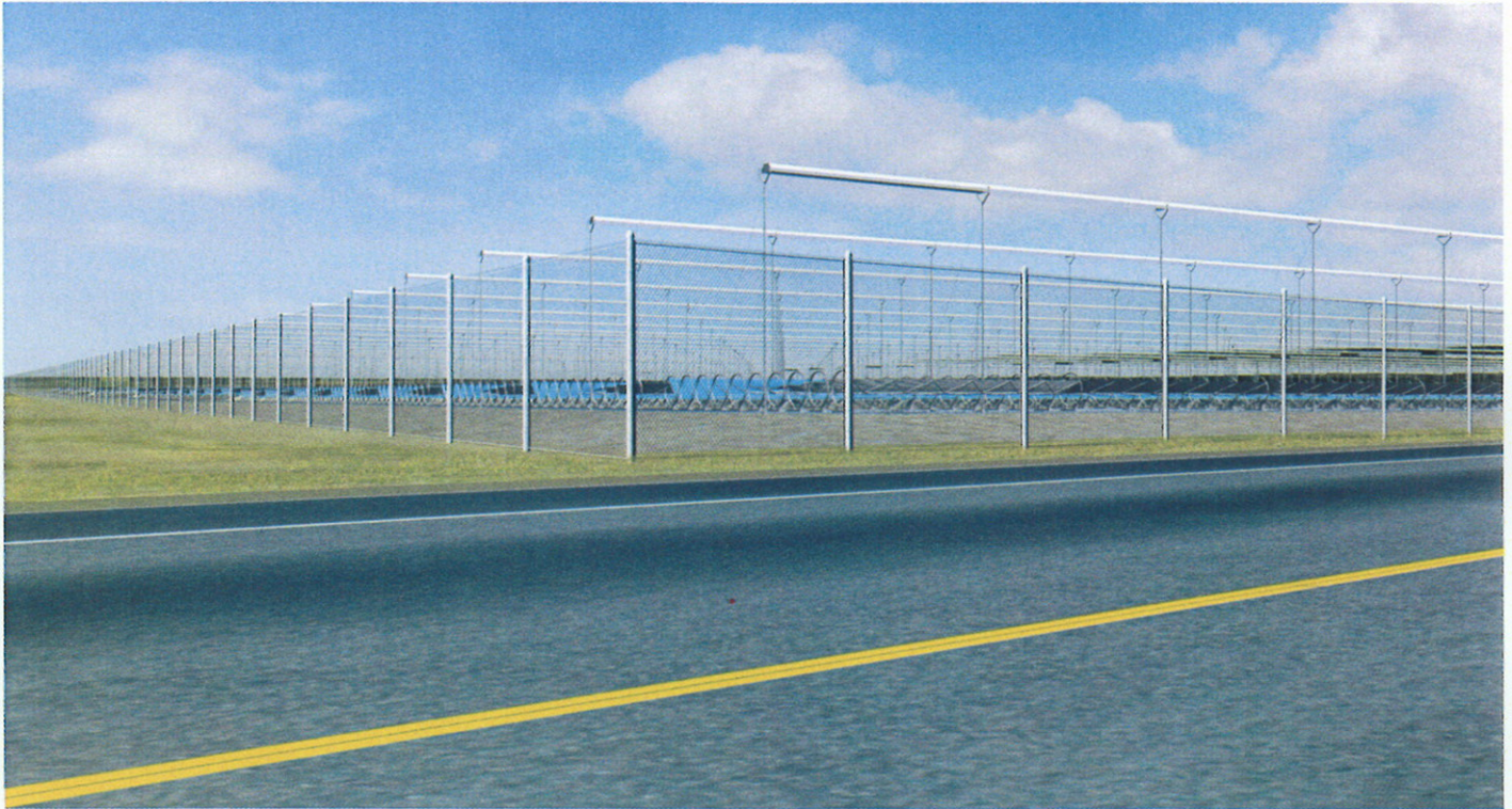
Figura 2 - Progetto di un impianto di 177 MW per la produzione di elettricità solare termica a concentrazione lineare tipo fresnel, la cui entrata in esercizio è prevista negli Stati Uniti nel 2010 (foto cortesia di Ausra).
