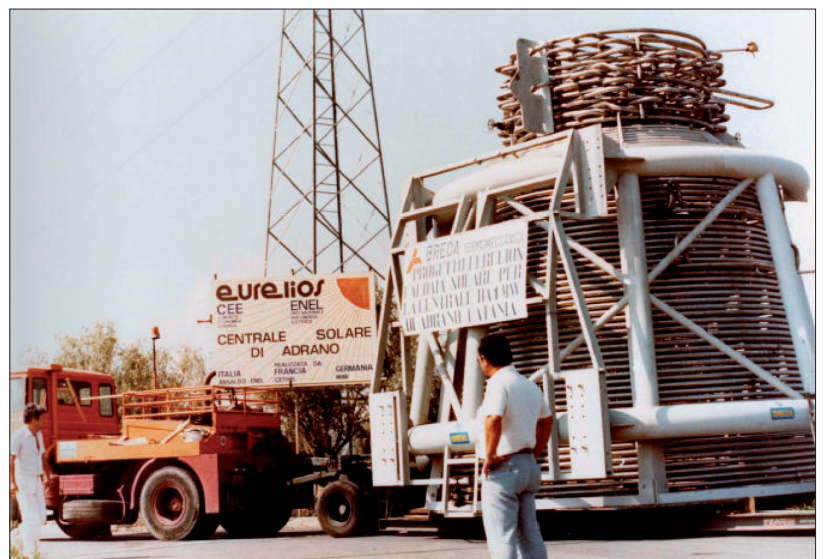
Fig. 1 – Fotografia della caldaia solare di Eurelios trasferita con trasporto speciale dalla Breda Milano ad Adrano (foto cortesia del Museo dell'Industria e del Lavoro di Brescia)
