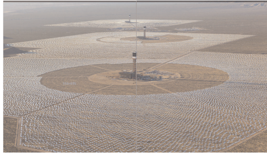
Figura 11 - Ivanpah: 14 km 2 la superficie occupata, circa 300.000 eliostati, 3 torri alte 150 m, 392 MWe (foto cortesia di BrightSource Energy, 2013).
