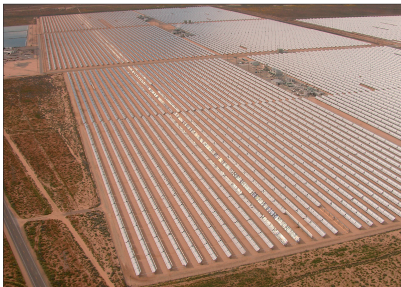
Fig. 2 – Vista dall'alto degli impianti solari di Kramer Junction (SEGS III, IV, V, VI, VII 1 installati dalla LUZ tra il 1986 e il 1988, di potenza pari a 30 MWe ciascuno
