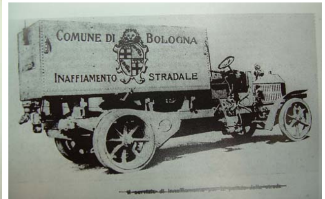
Il servizio di inaffiamento per il pulito della strada.
