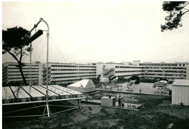
Fig. 7 – Station solaire de l'Université de Marseille, avec les bâtiments des laboratoires en arrière plan. Au premier plan, la Chaudière solaire 50 kW mise au point avec la collaboration de Giovanni Francia, environ 1965.
